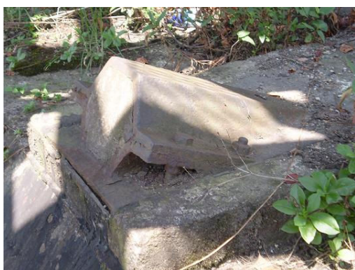
図4 メインケーブルの定着部
