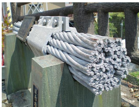
図3 メインケーブルの一部
