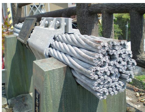
図3 メインケーブルの一部
