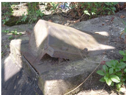
図4 メインケーブルの定着部
