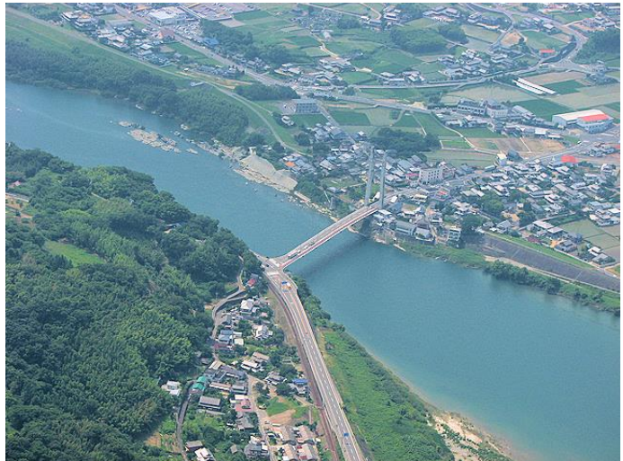
写真 2 上空から見た岩津橋(右岸下流側より)
