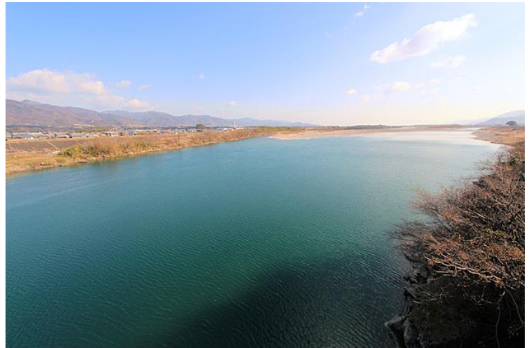
写真 4 岩津橋の下流（右岸橋詰より）
