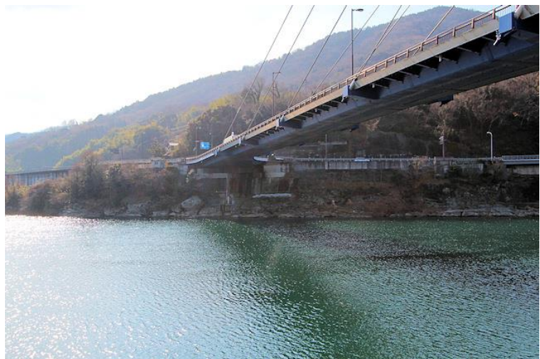
写真 3 箱桁の様子(左岸下流側より)
