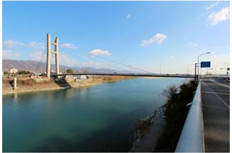
写真 1 岩津橋(右岸上流側より)
