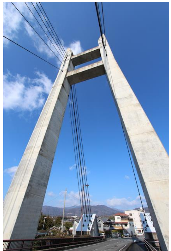
写真 5 主塔とアンカーレッジ
