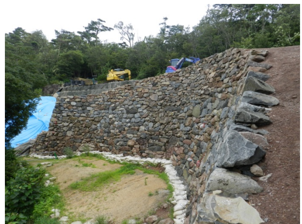
写真-4 積み直し工事完了後の城門南側城壁 (2013年7月撮影)
