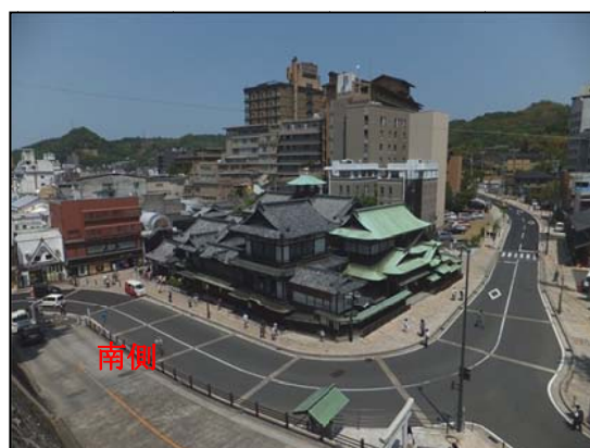
本館の全容(右手緑色の屋根が又新殿)
