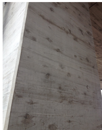
写真 3 北側のドーム支柱
