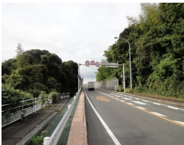
写真3 浦戸大橋入口（桂浜側）
