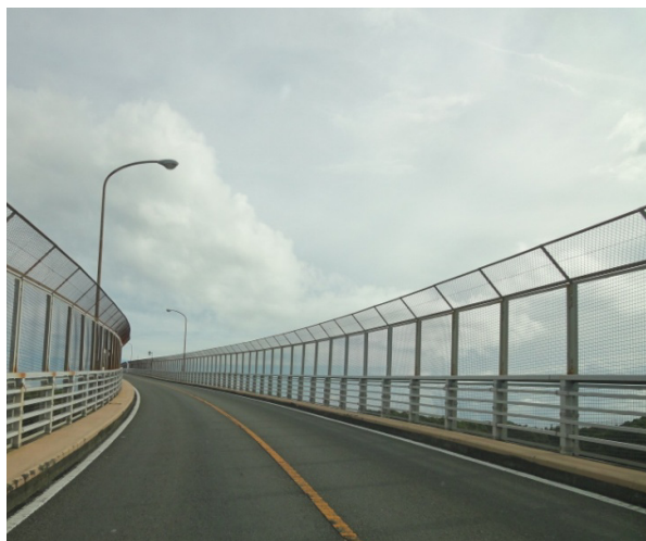
写真2 浦戸大橋(車道)
