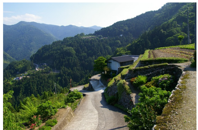
写真3 複雑な曲線を描く石積み
