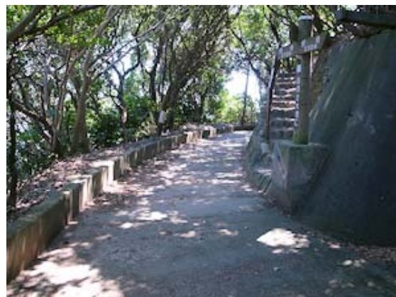
写真 6 移動式探照灯用の環状路
