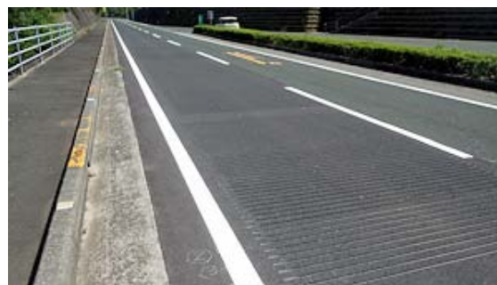
写真 8 佐田岬メロディー道路（施工部）
