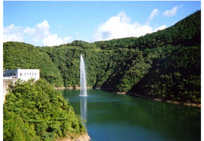
写真-2 ダム天端からの風景
