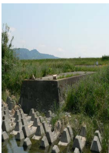
写真-1 様々な形の根固めブロックを施した重信川水制
