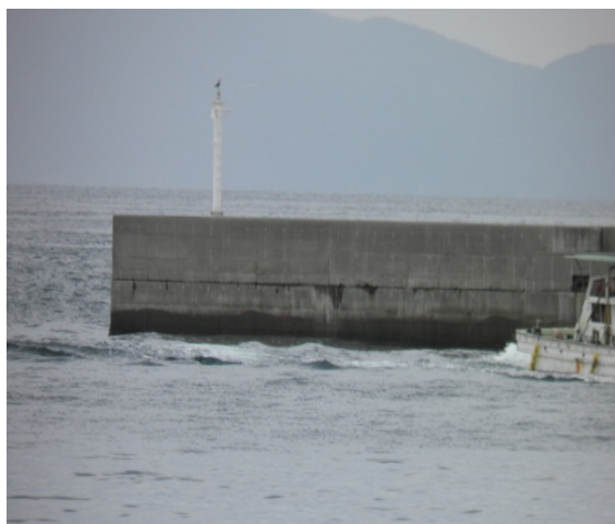
写真2 池島地区第一防波堤
