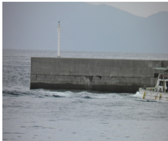
写真2 池島地区第一防波堤
