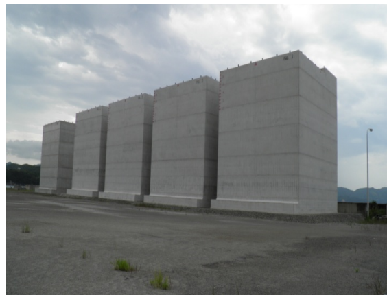
写真3 巨大ケーソン(施工中)
