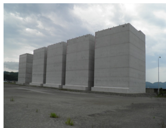
写真3 巨大ケーソン(施工中)
