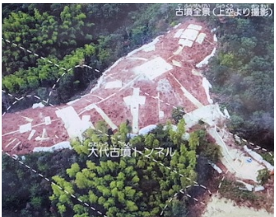
写真3 大代古墳トンネルを上空より臨む(手前が下り線)
