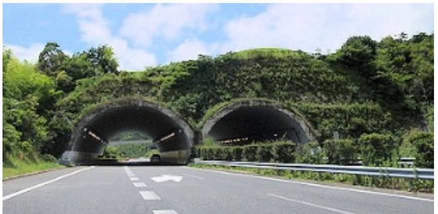
写真2 大代古墳トンネル(上り線)
