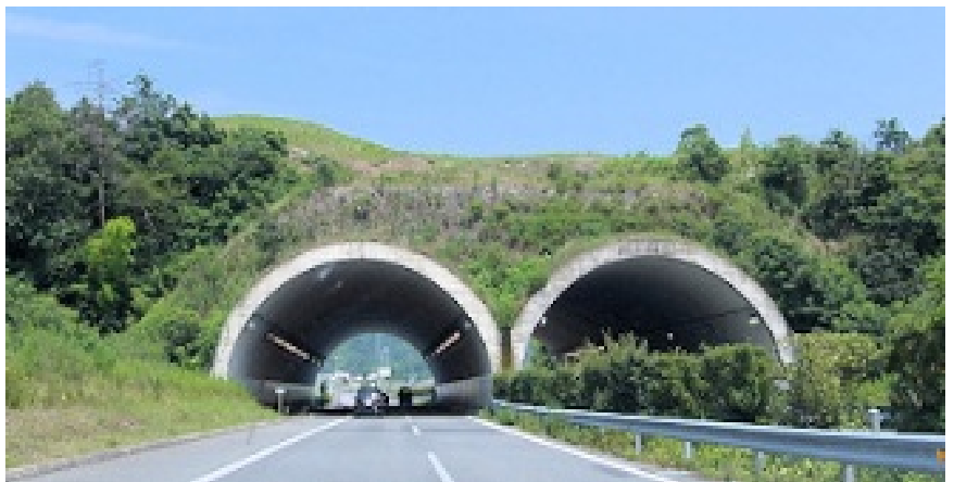
写真1 大代古墳トンネル(下り線)
