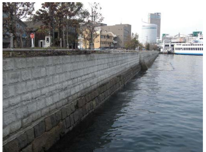
写真1 西方向に見た現在の北浜物揚場
