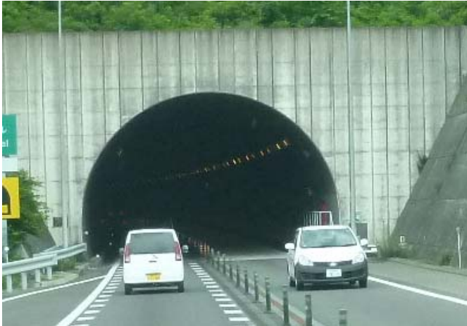
写真1 トンネル抗口1
