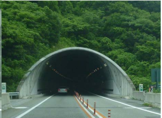
写真2 トンネル抗口2
