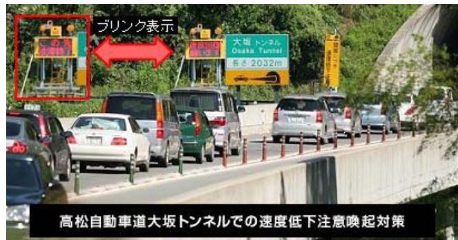
写真 5 LED 標識の活用による注意喚起 (NEXCO 西日本 HP より)
