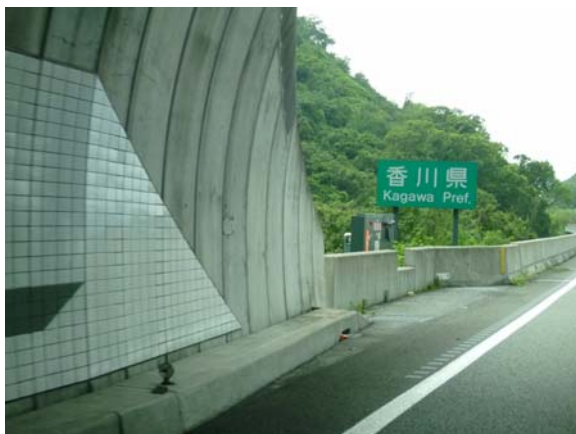
写真3 抗口の形状(抗口側面)
