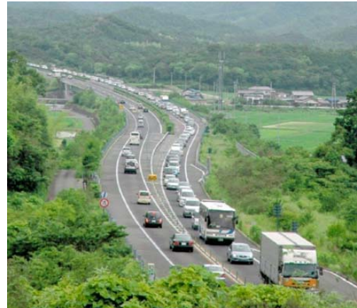
写真 4 大坂トンネル付近渋滞状況 (四国新聞 HP より)
