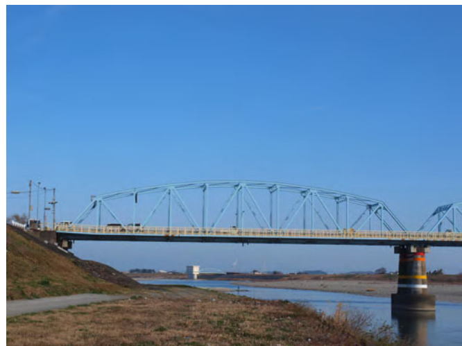
写真2 北端：鋼トラス橋
