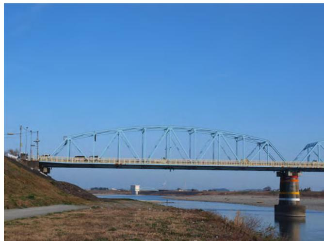
写真2 北端：鋼トラス橋
