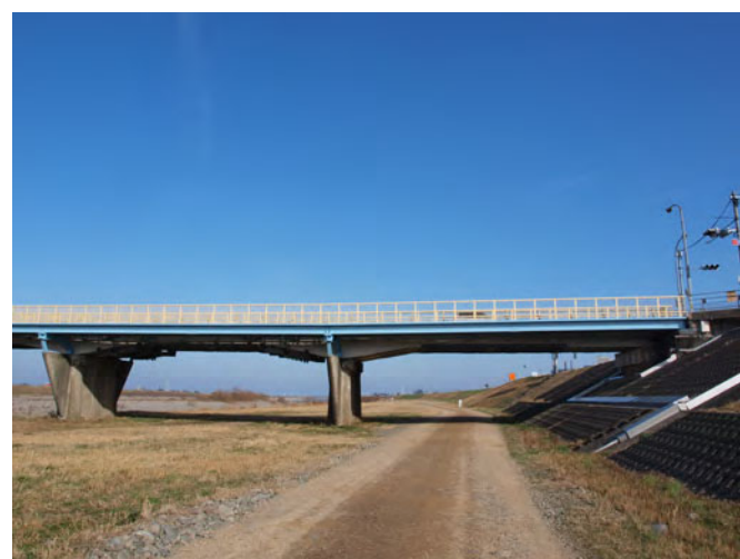
写真3 南端：鉄筋コンクリート橋
