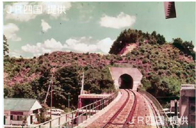
写真2 地山が残っていた当時の町内トンネル
