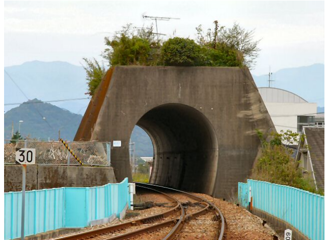
写真1 海部駅から望む町内トンネル（現在）
