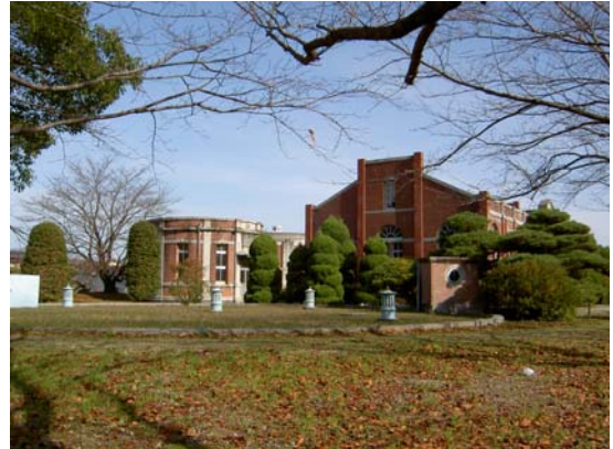
写真一 集合井と旧ポンプ棟
