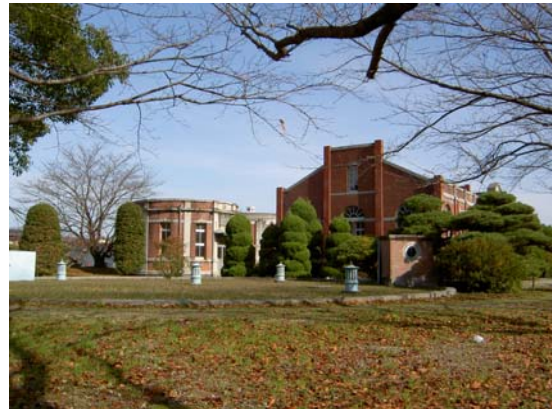
写真一 集合井と旧ポンプ棟
