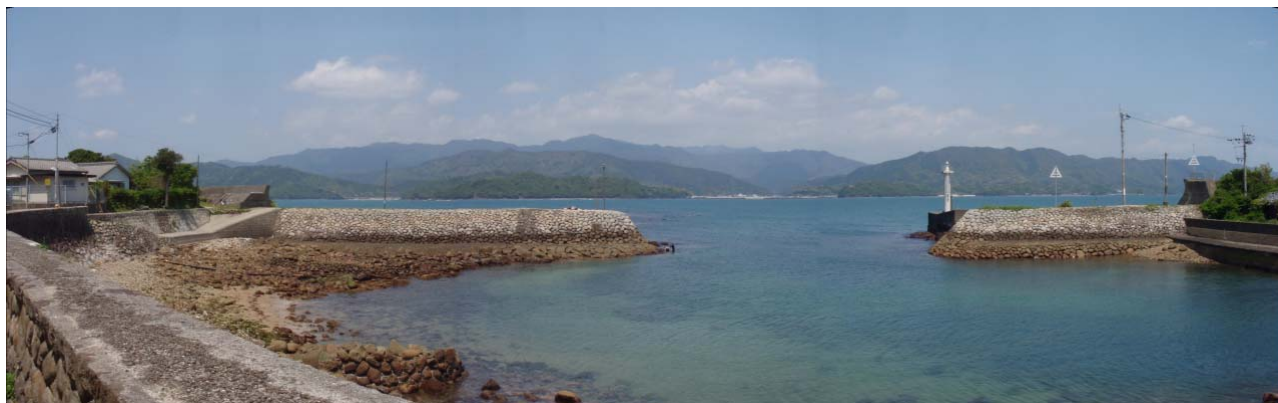
写真2 石造りの防波堤（対岸に白く見えているのは牟岐町市街地）
