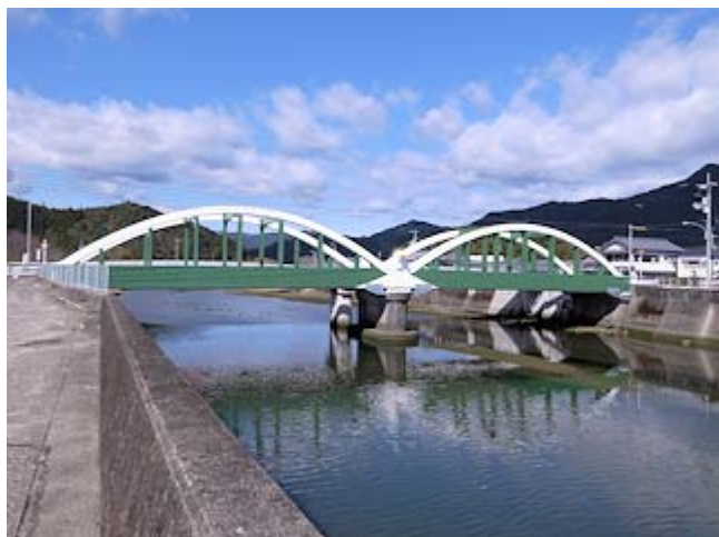
写真1 穴喰橋全景(下流右岸側から望む)
