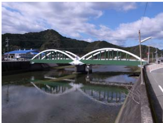
写真2 穴喰橋全景(下流左岸側から望む)
