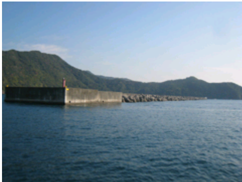
写真1 須崎津波防波堤(西) 1)
