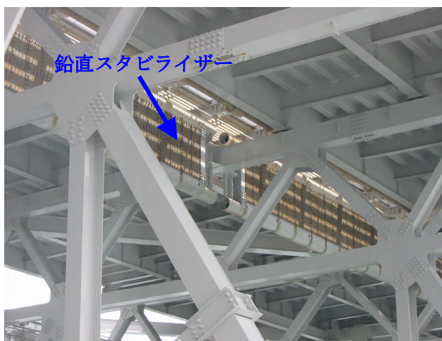
写真-5 車道裏側
