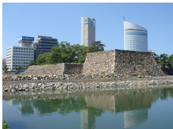
図－２ 高松城天守台解体前状況
