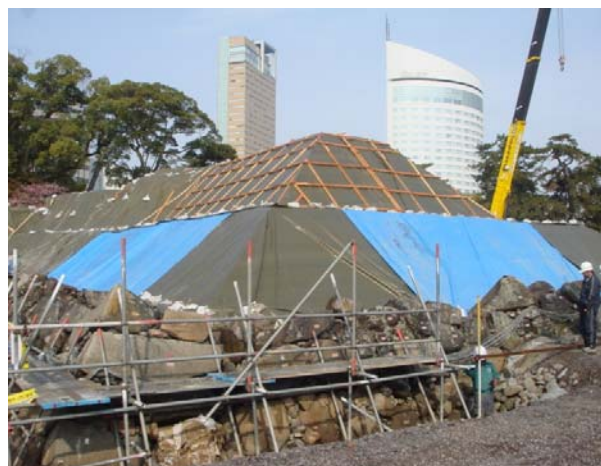
図-3 高松城天守台修復工事状況
