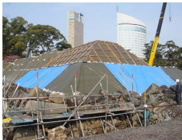
図-3 高松城天守台修復工事状況
