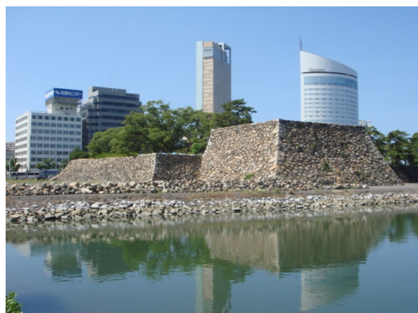
図－2 高松城天守台解体前状況
