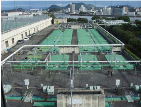
写真-1 沈殿槽及び反応タンク
