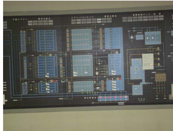
写真－2 運転管理室
