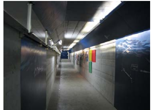
写真 10 監査廊 (ギャラリー)
