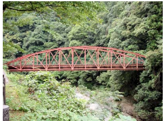
写真1 打除鉄橋（全体）
