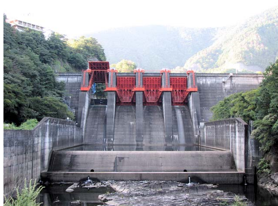
写真13 新宮ダム堤体と管理所
