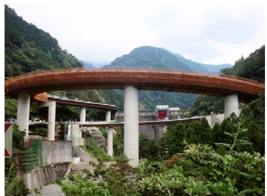
写真3 鹿森ダムと建設中のループ橋
