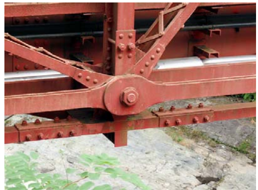
写真2 打除鉄橋のピン構造
