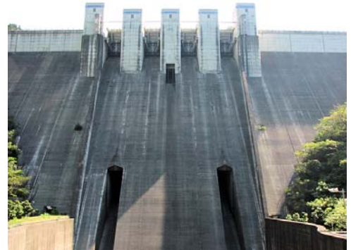
写真 9 富郷ダム堤体
