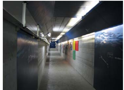
写真 10 監査廊 (ギャラリー)
