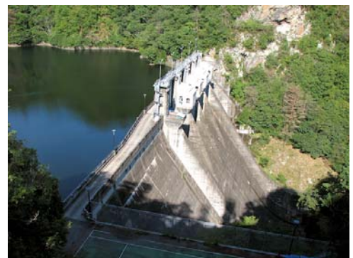
写真 12 柳瀬ダム堤体
