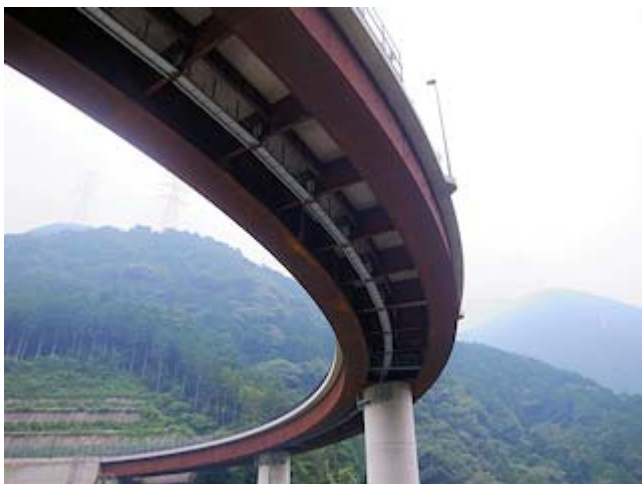
写真5 第二青龍橋の箱桁(耐候性鋼材裸使用)
