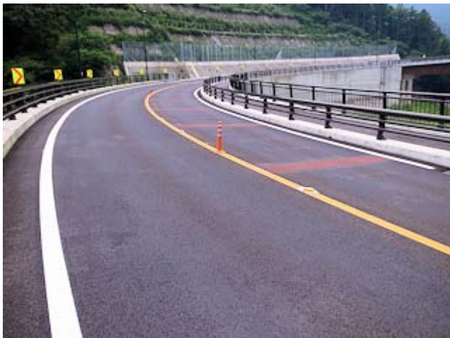
写真3 第一青龍橋の路面
