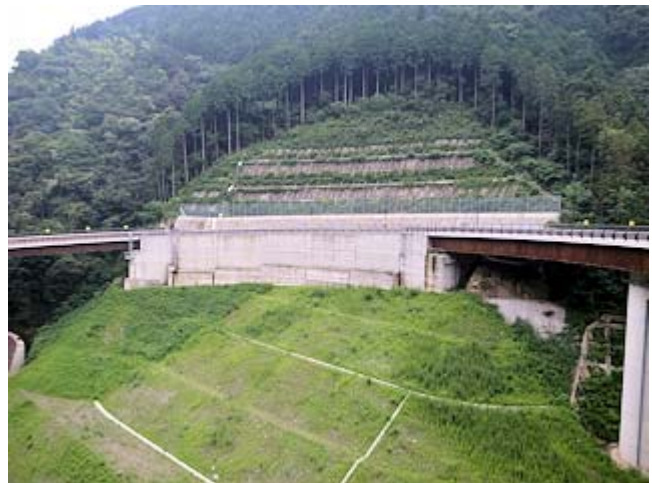
写真4 第一青龍橋(左)・第二青龍橋(右)の結合部
