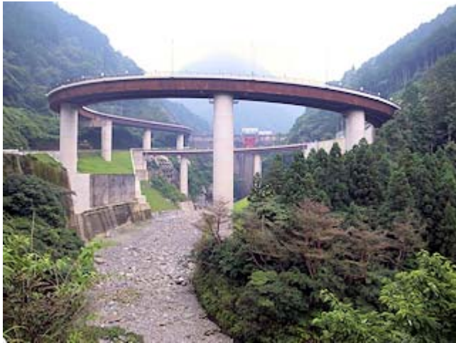
写真1 第一・第二青龍橋全景(下流側から望む)
