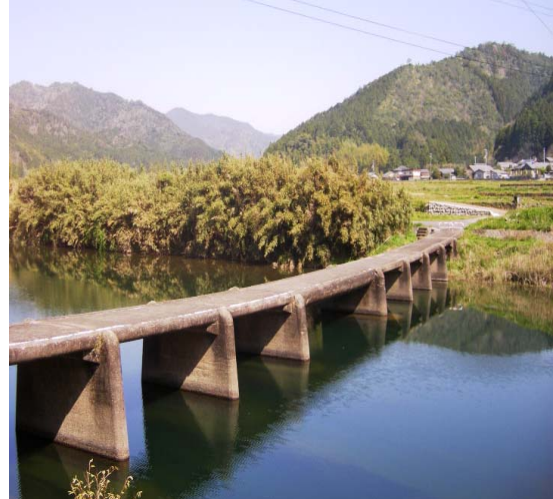
写真 3 一斗俵沈下橋（全景）
