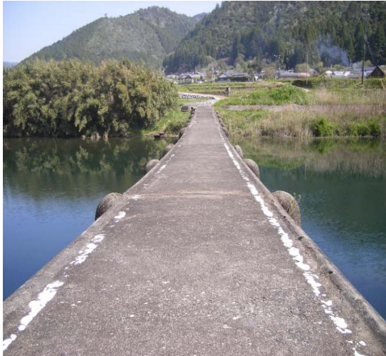
写真 2 一斗俵沈下橋
