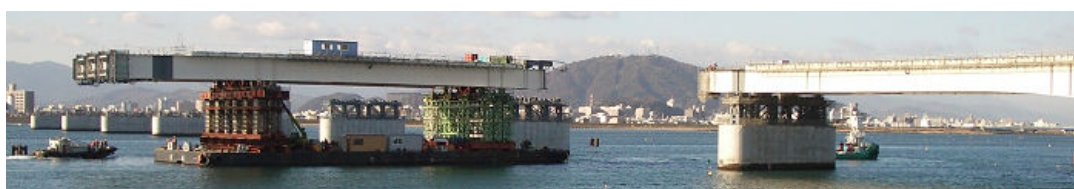
写真1 台船施工方式
