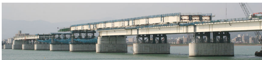
写真2 送り出し工法
