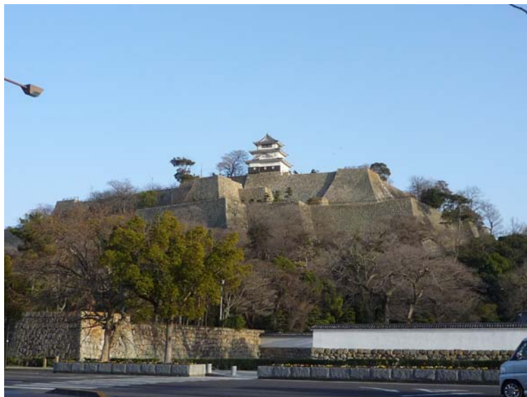
写真一 丸亀城(北西方向)景観 れています。
