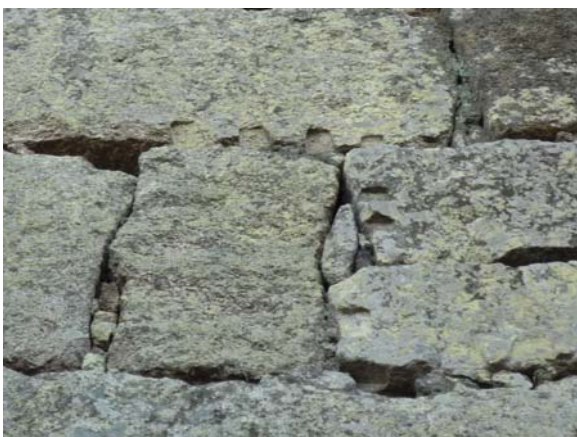
写真—3 打ち込みハギと矢穴の跡
