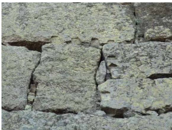
写真三 打ち込みハギと矢穴の跡
