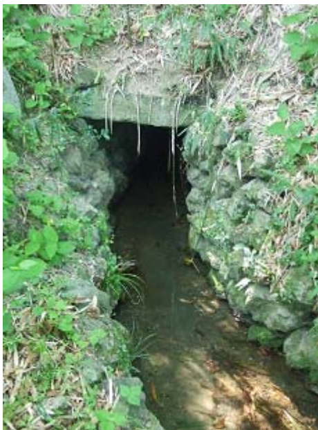
写真－1 掘割（中谷川側）
