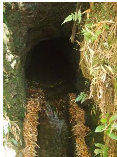
写真－2 掘割（奈路側）
