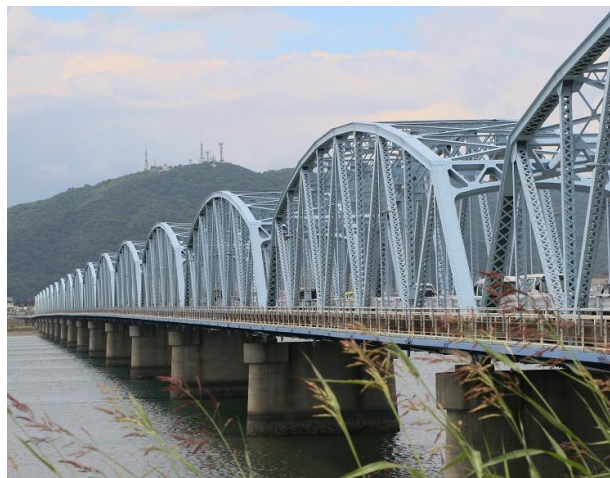
写真-2 吉野川橋
