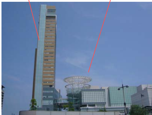
図2 高松シンボルタワー (南側から)
