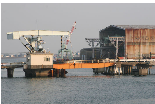
写真-2 可動部（橙色の部分）
