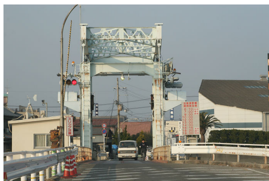
写真-3 片側一車線の可動部
