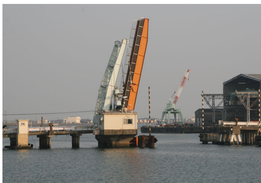
写真-5 全開状態（およそ90秒かけて最大79°まで開きます）
