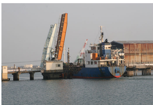
写真-6 船の通過（開閉部は船の横幅ギリギリです）
