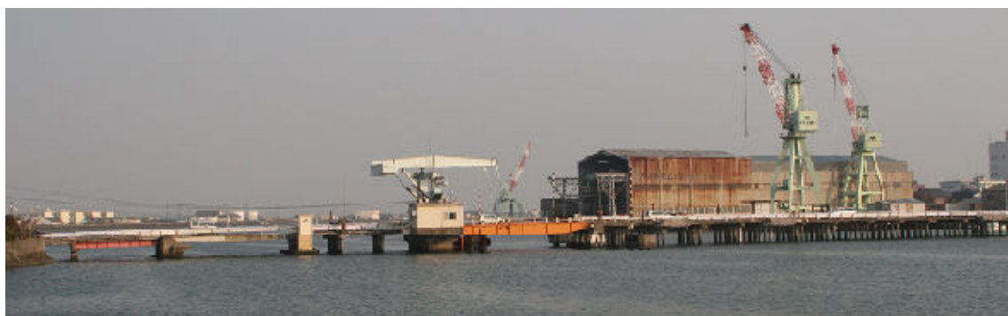
写真-1 加賀須野橋全景
