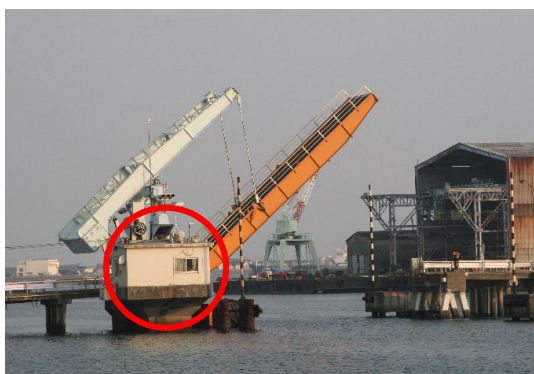
写真-4 操作所（○で囲った建物で開閉操作をおこなっています）
