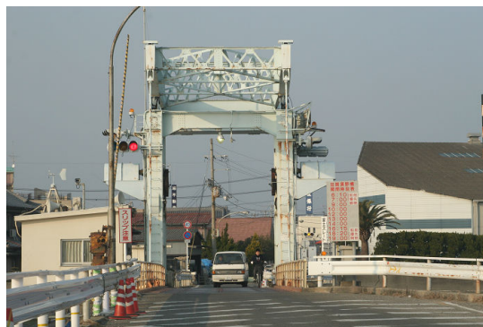
写真-3 片側一車線の可動部
