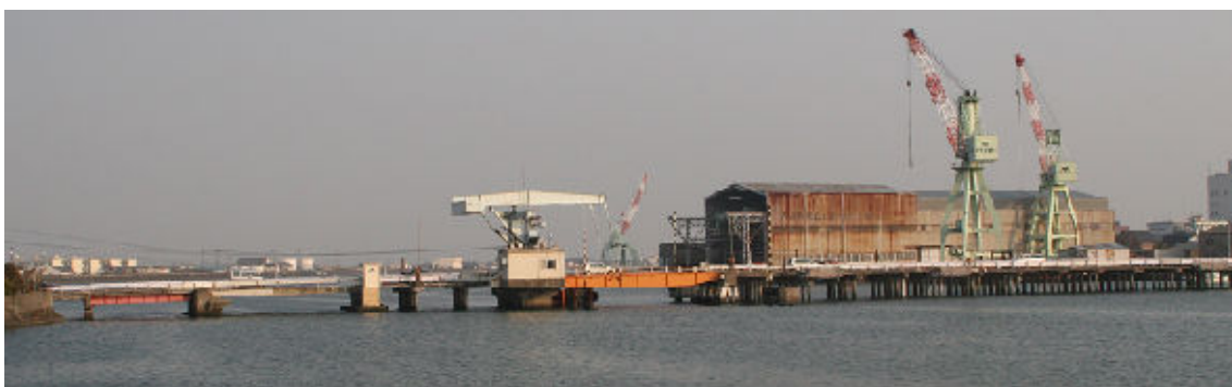
写真-1 加賀須野橋全景
