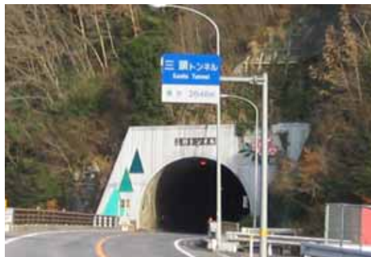
図1, 三頭トンネル(香川県側から撮影)
