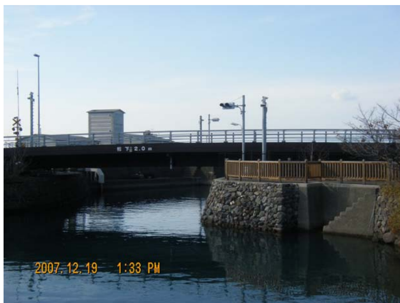
写真－１ 可動橋閉時
